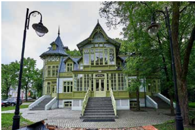
FOT. 15. Zakończono rewitalizację najstarszej części Białej Fabryki/ FOT. ARCHIWUM UMŁ
