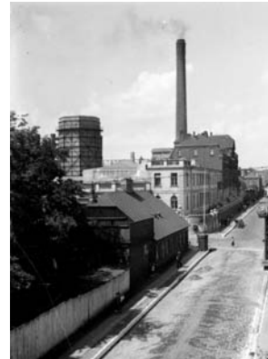
Ulica Targowa, gdzie działała łódzka gazownia. W głębi elektrownia EC1.
